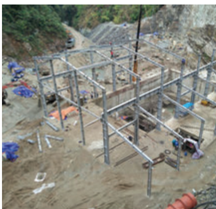
Gia công và lắp đặt kết cấu thép nhà máy thủy điện Xím Vàng 2 Fabrication and installation of steel structure of Xim Vang 2 hydropower plant
