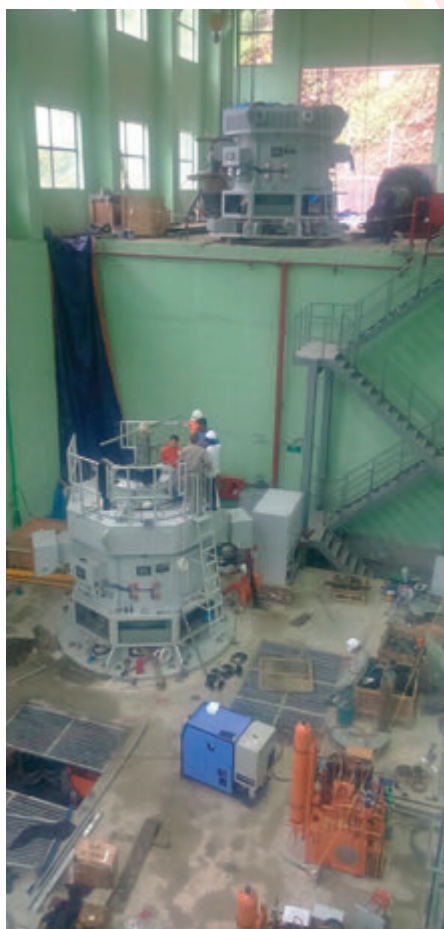
Thi công lắp đặt thiết bị cơ điện nhà máy thủy điện Nậm Ban 2 Fabrication and installation of electromechanical equipment of Nam Ban 2 hydropower plant
