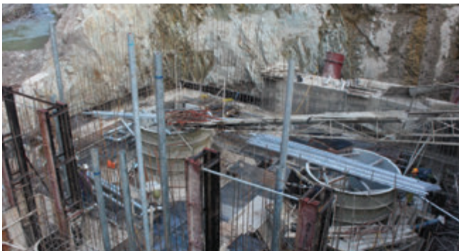
Thi công nhà máy thủy điện Nậm Chim 2 Construction of Nam Chim 2 hydropower plant
