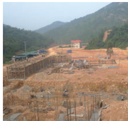
Thi công móng nhà ga đi tuyến cáp treo Chùa Ngọa Vân Construction of the railway station by cable car Chùa Ngọa Vân
