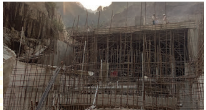
Thi công nhà máy thủy điện Nậm Chim 2 Construction of Nam Chim 2 hydropower plant
