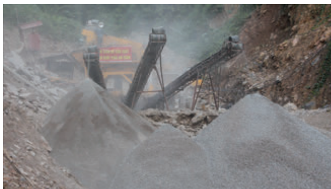
Sản xuất đá xây dựng phục vụ thi công thủy điện Xím Vàng 2 Production of construction stone for Xim Vang 2 hydropower plant
