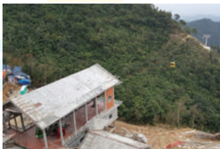
Thi công bê tông ga đến tuyến cáp treo Chùa Ngọa Vân Construction of concrete station to cable car Ngọa Vân
