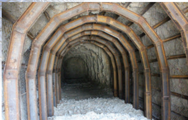
Gia cố tạm cửa ra hầm thủy điện Nậm chim 2 To consolidate the temporary exit of Nam chim 2
