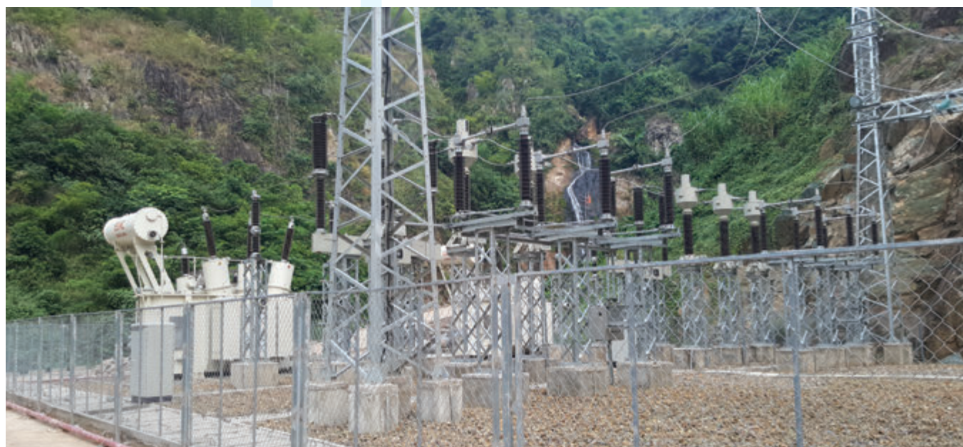
Thi công trạm biến áp 110kv nhà máy thủy điện Nậm Chim 2 Construction of 110 kV transformer station of Nam Chim 2 Hydropower Plant
