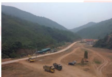
Thi công san lấp mặt bằng nhà ga đi tuyến cáp treo Chùa Ngọa Vân Construction of the leveling station of the Ngọa Vân cable car station
