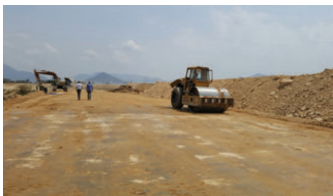
Thi công nền đường khu dân cư Thái Xuân Construction of the road of Thai Xuan residential area
