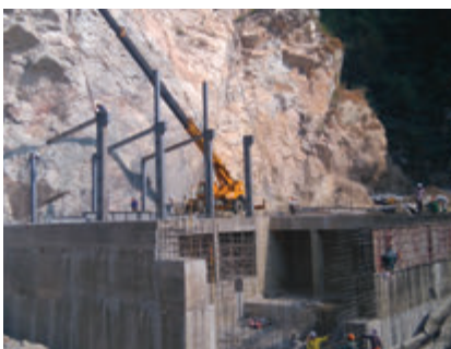
Thi công nhà máy thủy điện Xím Vàng 2 Executing Xim Vang Hydropower Plant 2
