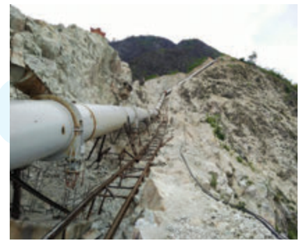
Gia công và lắp đặt đường ống áp lực thủy điện Xím Vàng 2 Fabrication and installation of hydroelectric pressure pipe Xim Vang 2
