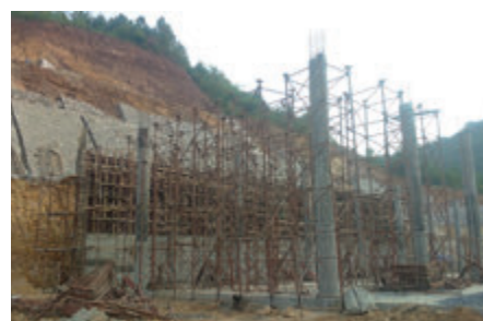
Thi công bê tông nhà ga đi tuyến cáp treo Chùa Ngọa Vân Construction of the railway
