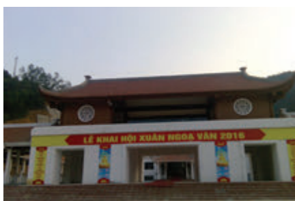
Thi công cổng tam quan Ga đi tuyến cáp treo Chùa Ngọa Vân Construction of the gate of the
