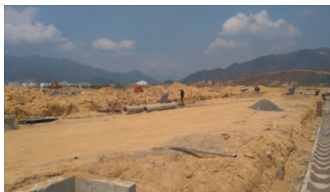
Thi công hệ thống thoát nước khu dân cư Thái Xuân Construction of drainage system in Thai Xuan residential area
