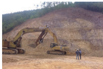
Thi công san lấp mặt bằng nhà ga đi tuyến cáp treo Chùa Ngọa Vân Construction of the leveling station of the Ngọa Vân cable car station
