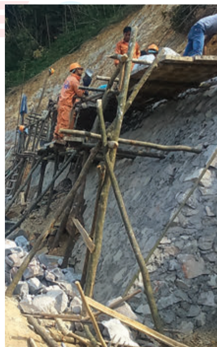
Thi công kè đá chắn đất tuyến cáp treo Chùa Ngọa Vân Construction of cable car retaining wall of Ngọa Vân Pagoda
