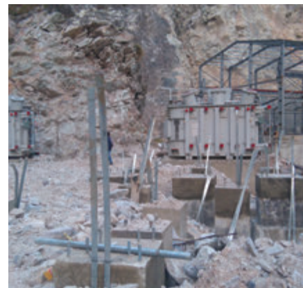
Thi công trạm biến áp 110kv nhà máy thủy điện Xím Vàng 2 Construction of transformer station 110kv Xim Vang 2 hydropower plant
