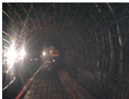
Thi công cốt thép áo hầm dẫn nước thủy điện Xím Vàng 2 Construction of reinforced tunnel for Xim Vang power plant 2
