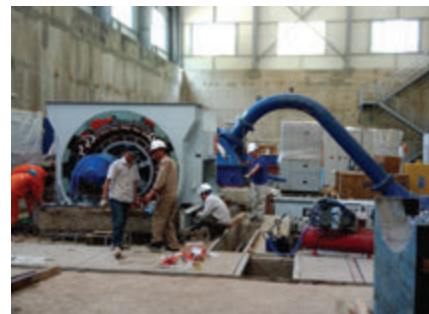
Thi công lắp đặt thiết bị cơ điện nhà máy thủy điện Xím Vàng 2 Executing and installing electromechanical equipment for Xim Vang 2 Hydropower Plant 2
