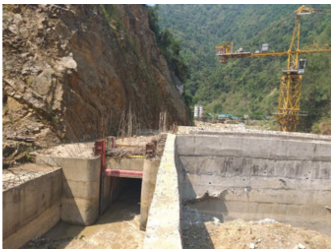
Thi công cống dẫn dòng thủy điện Nậm Ban 3 Hydroelectric drain Construction Nam Ban 3
