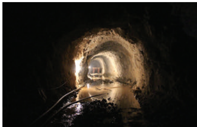
Thi công đào hầm thủy điện Nậm chim 2 Construction of Nam Chug 2 Hydropower Plant
