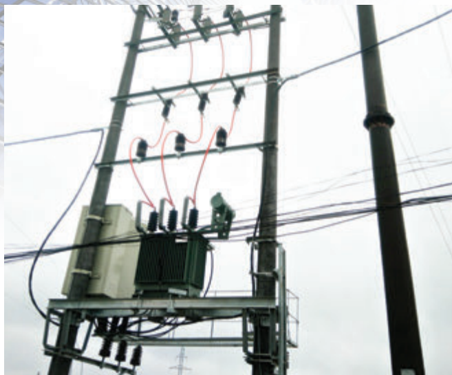
Thi công Lắp đặt trạm 35kv, Lâm Thao, Phú Thọ Construction of 35kv station, Lam Thao, Phu Tho
