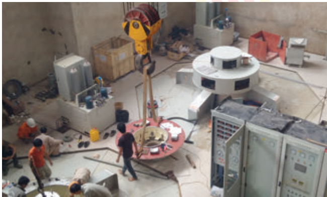
Thi công lắp đặt thiết bị cơ điện nhà máy thủy điện Nam Chim 2 Installation and installation of electromechanical equipment Nam Chim 2 Hydropower Plant
