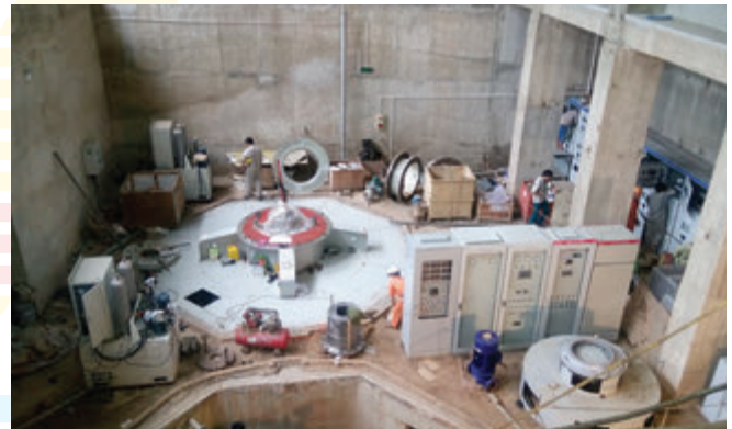
Thi công lắp đặt thiết bị cơ điện nhà máy thủy điện Nam Chim 2 Installation and installation of electromechanical equipment Nam Chim 2 Hydropower Plant
