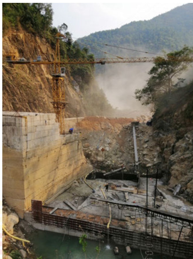
Thi công bê tông đập đầu mối thủy điện Nậm Ban 3 Construction of dam concrete clue hydroelectric Nam Ban 3
