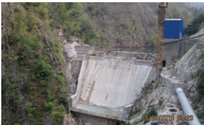
Thi công bê tông đập đầu mối thủy điện Nậm Chim 2 Construction of Nam Chim 2 hydropower dam
