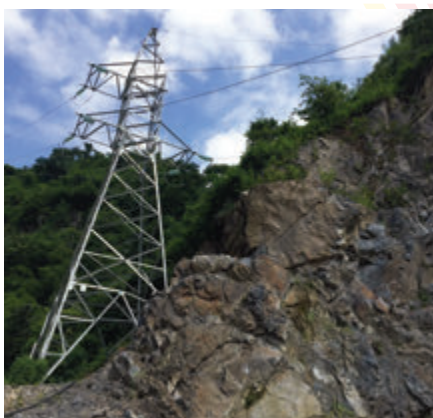
Thi công đường dây 110kv thủy điện Xím Vàng 2 Construction of 110kV Xim Vang 2 Hydropower Plant
