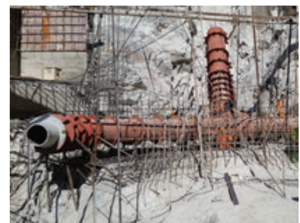
Thi công nhà máy thủy điện Xím Vàng 2 Executing Xim Vang Hydropower Plant 2
