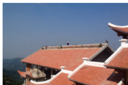
Thi công hoàn thiện ga đến tuyến cáp treo Chùa Ngọa Vân Completion of the station to cable car Ngọa Vân
