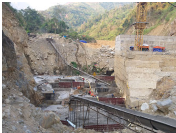
Thi công bê tông đập đầu mối thủy điện Nậm Ban 3 Construction of dam concrete clue hydroelectric Nam Ban 3
