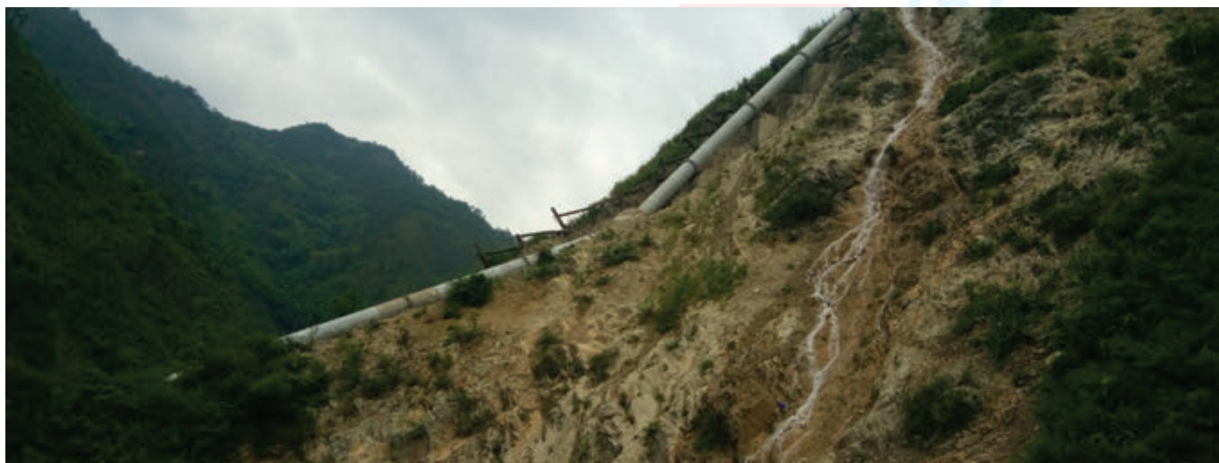
Gia công và lắp đặt đường ống áp lực thủy điện Nậm Chim 2 Fabrication and installation of Nam Chim 2 hydropower pipeline
