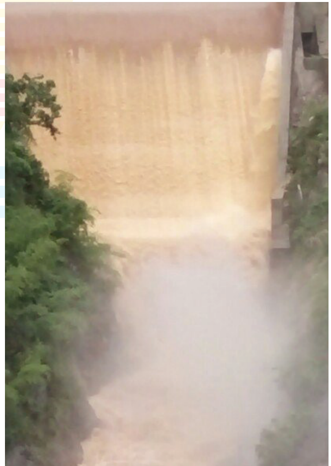
Thi công đập đầu mối thủy điện Nậm Chim 2 Construction of Nam Chim Hydropower dam 2
