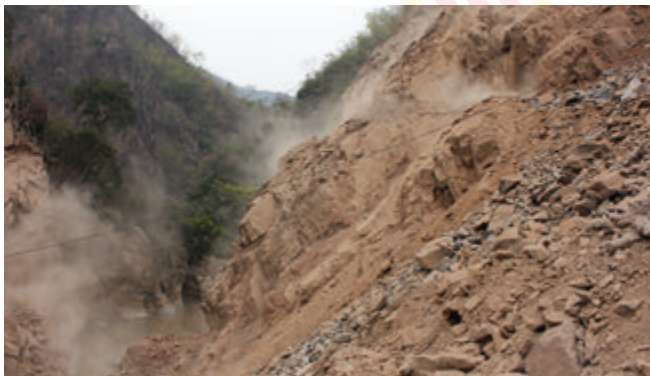
Thi công bóc đất đá đập đầu mối thủy điện Nậm Chim 2 Construction of earthen dams of Nam Chim 2 hydropower dam
